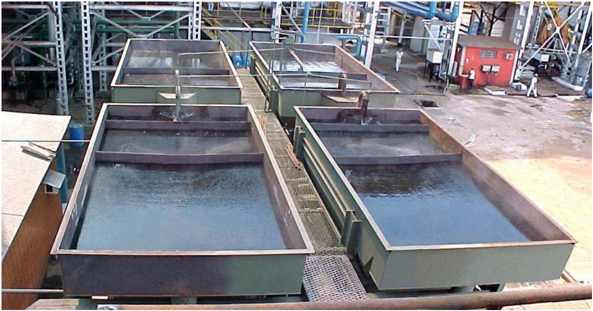
Figuras 7 y 8: Unidad de tratamiento compuesta por cuatro células de decantación para el procesamiento de 2.650 gal/min (600 m 3 /h) de agua de ceniza.
